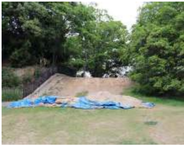
墳丘の土流出状況
