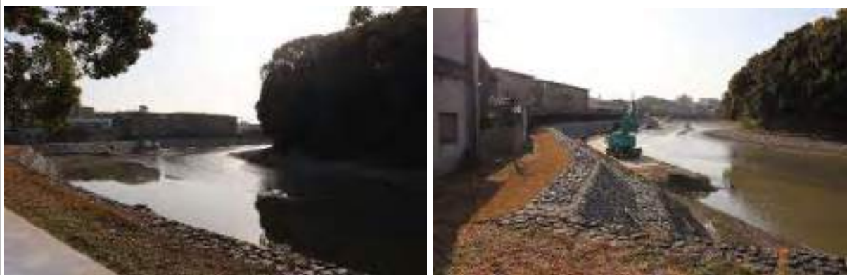
A：後円部外方から南西方向を望む
