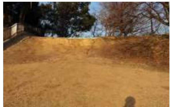
西側：修繕未実施
