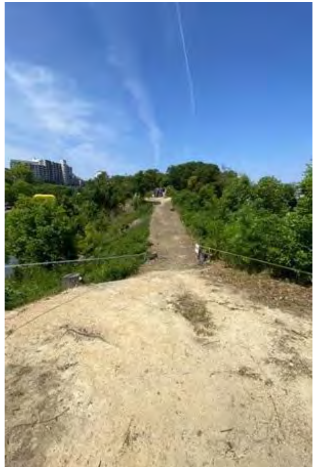
図4 墳丘盛土の流出危険箇所（後円部墳頂）
